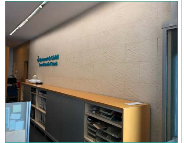
Adaptació de moble existent de fusta per col·locació de pilar metàl·lic
