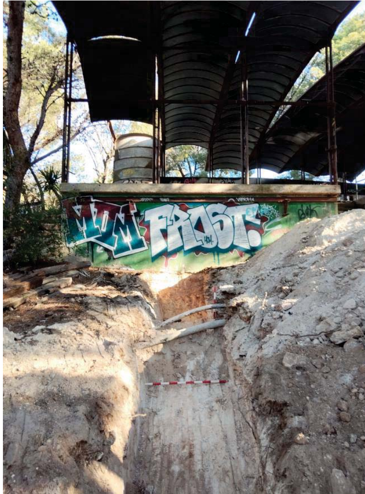
Figura 66. Vista general de la rasa 8
