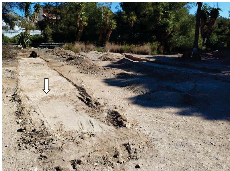
Figura 21. Vista general de les rases rasa 4, 3 i 1
