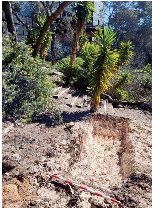
Figura 71. Vista general de la rasa 11
