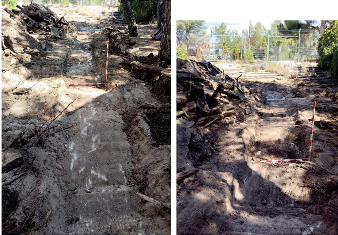
Figura 89-90. Vistes generals de la rasa 22.
