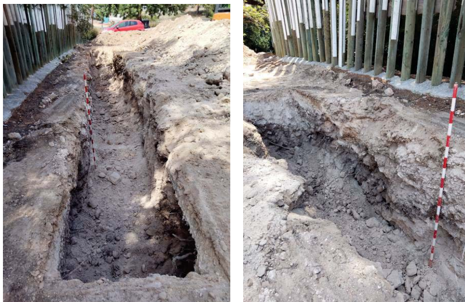
Figures 48-49. Vista general i detall de la rasa 18
