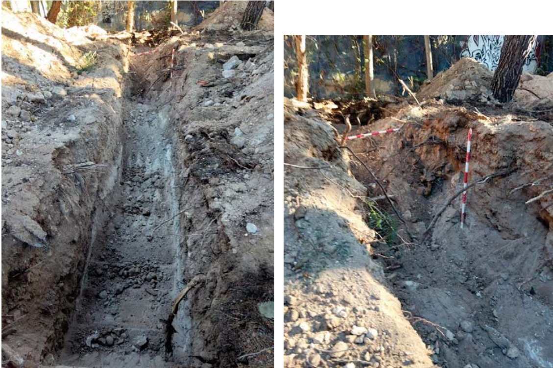
Figures 72-73. Vista general i detall de la rasa 12
