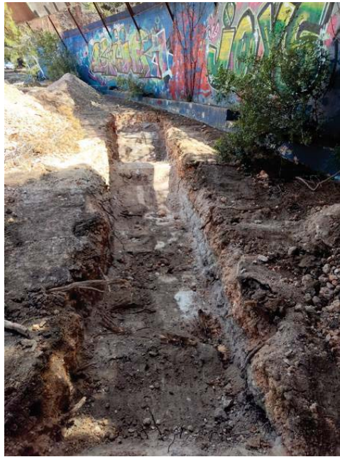
Figura 43. Vista general de la rasa 15
