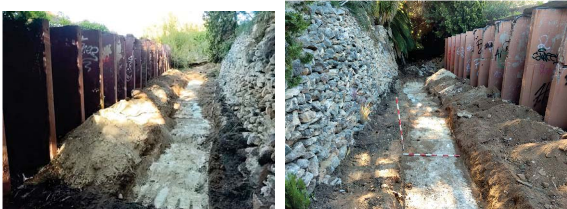
Figures 55-56. Vista general i detall de la rasa 2
