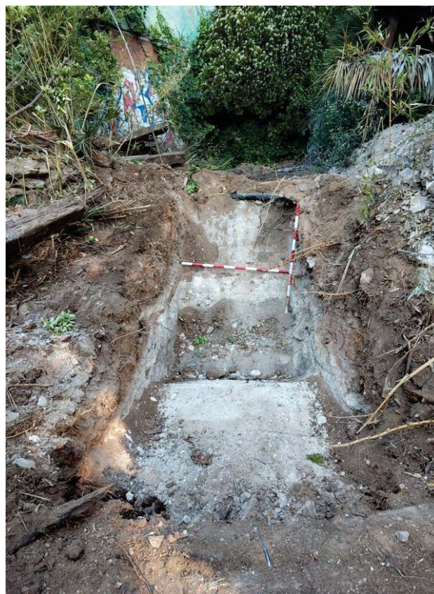
Figura 57. Vista general de la rasa 3
