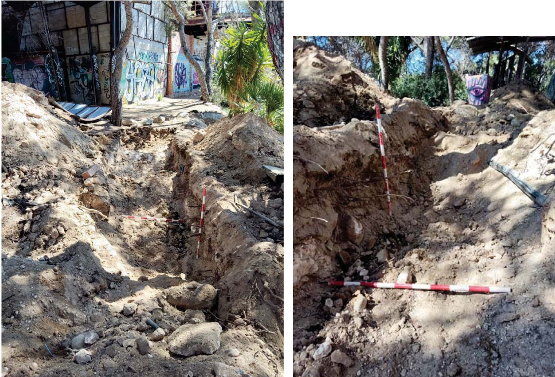
Figures 83-84. Vista general i detall de la rasa 19
