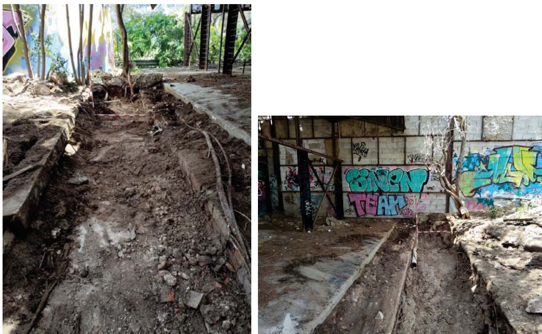
Figures 85-86. Vista general i detall de la rasa 20
