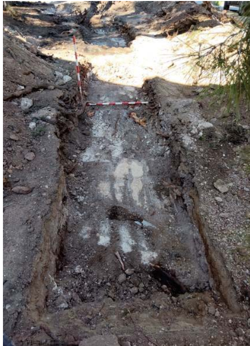
Figura 30. Vista general de la rasa 8
